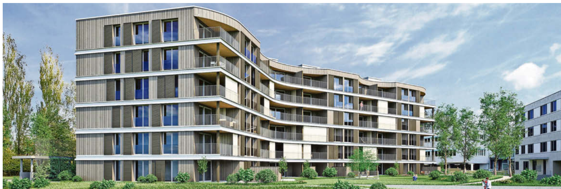
Die an der Huebwisstrasse in Fällanden entstehende Siedlung wird landesweit eine der grössten Holzbauten sein. Visualisierung: PD
